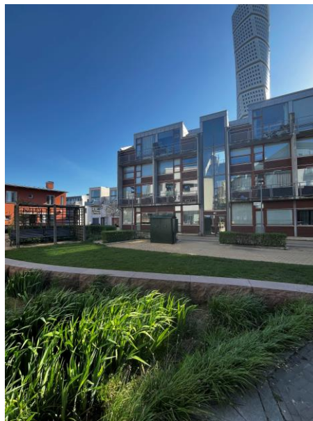
Figur 9 Fastigheten Skansen 1 i Västra hamnen, Malmö
